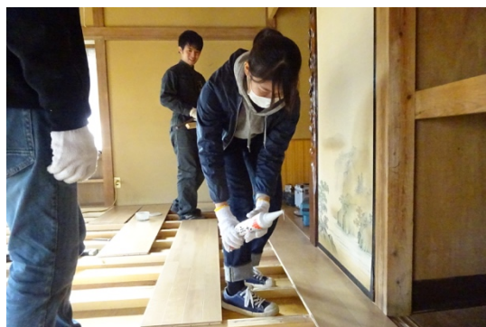
図6 フローリング材を固定する風景
