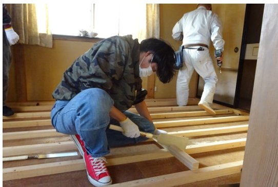
図4 根太材を切断する風景
