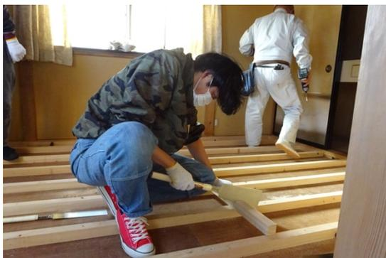
図4 根太材を切断する風景
