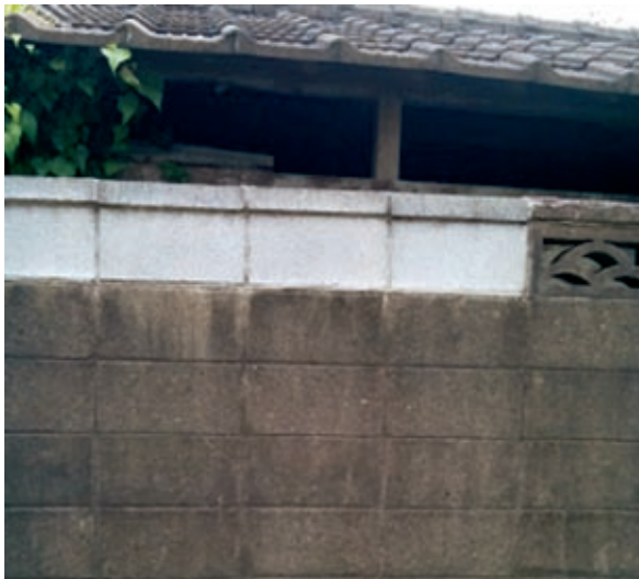
写真 2 崩れたブロックを修復した塀
