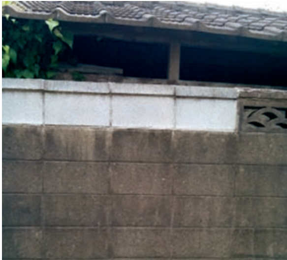
写真 2 崩れたブロックを修復した塀
