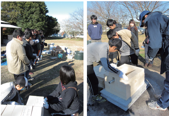
たたら製鉄の炉を組み上げる様子
